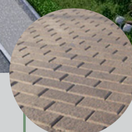
Мощение тротуарной плиткой
